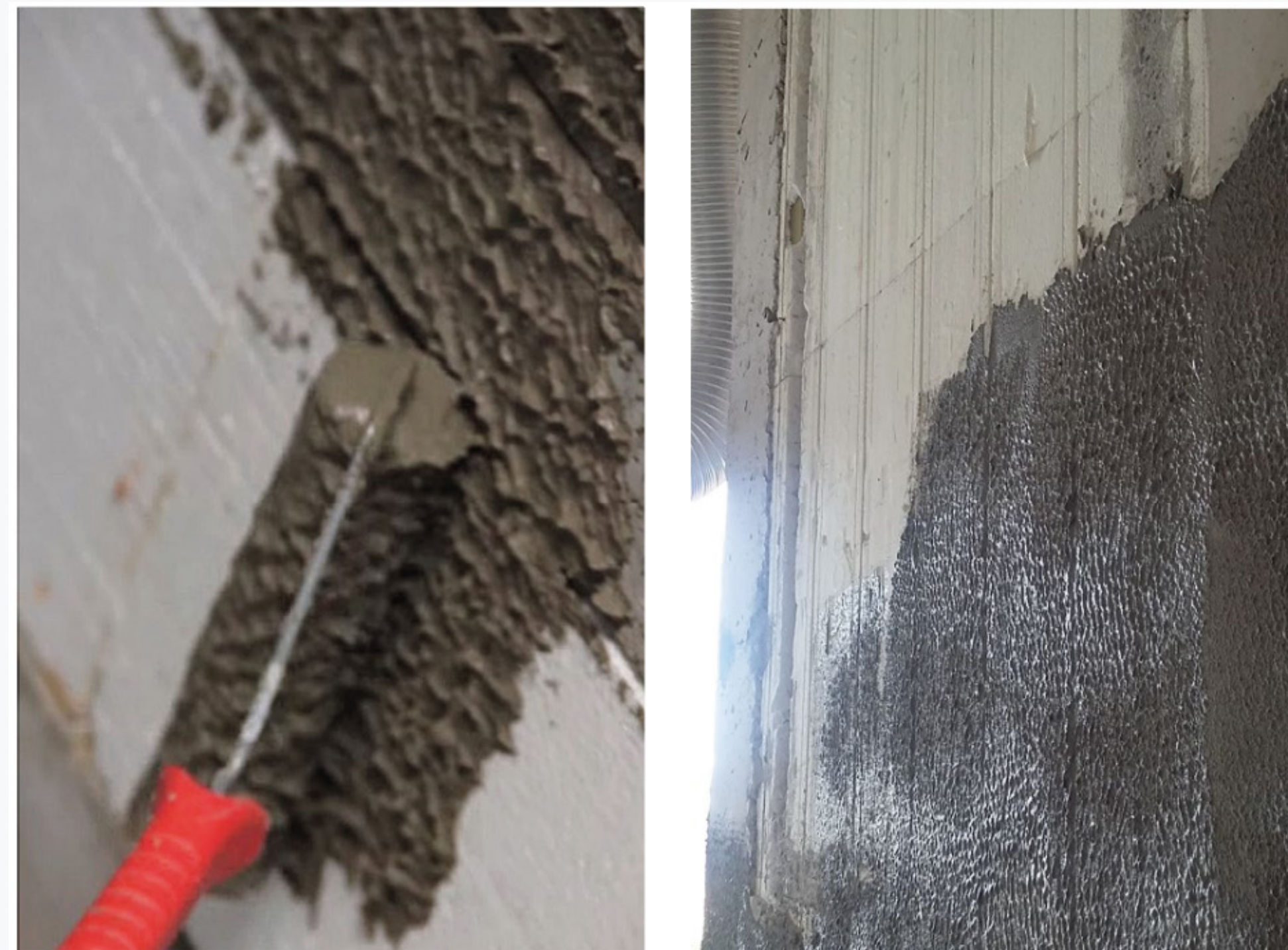
Figura 29: Aplicação do reboco
