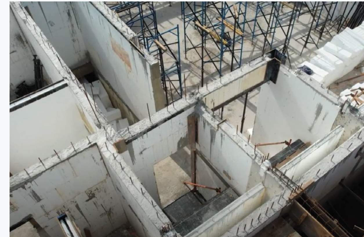
Figura 04: Paredes de concreto
