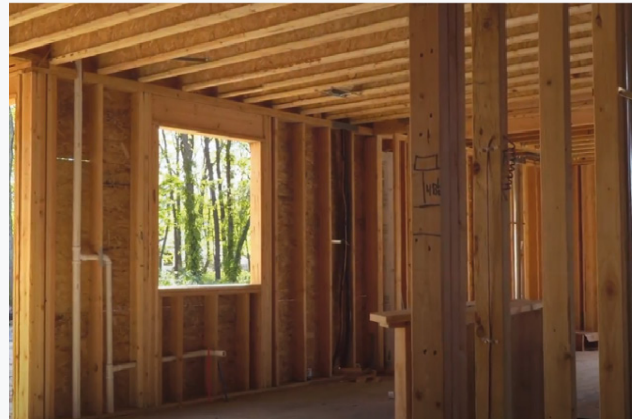
Figura 03: Parede Wood Frame
