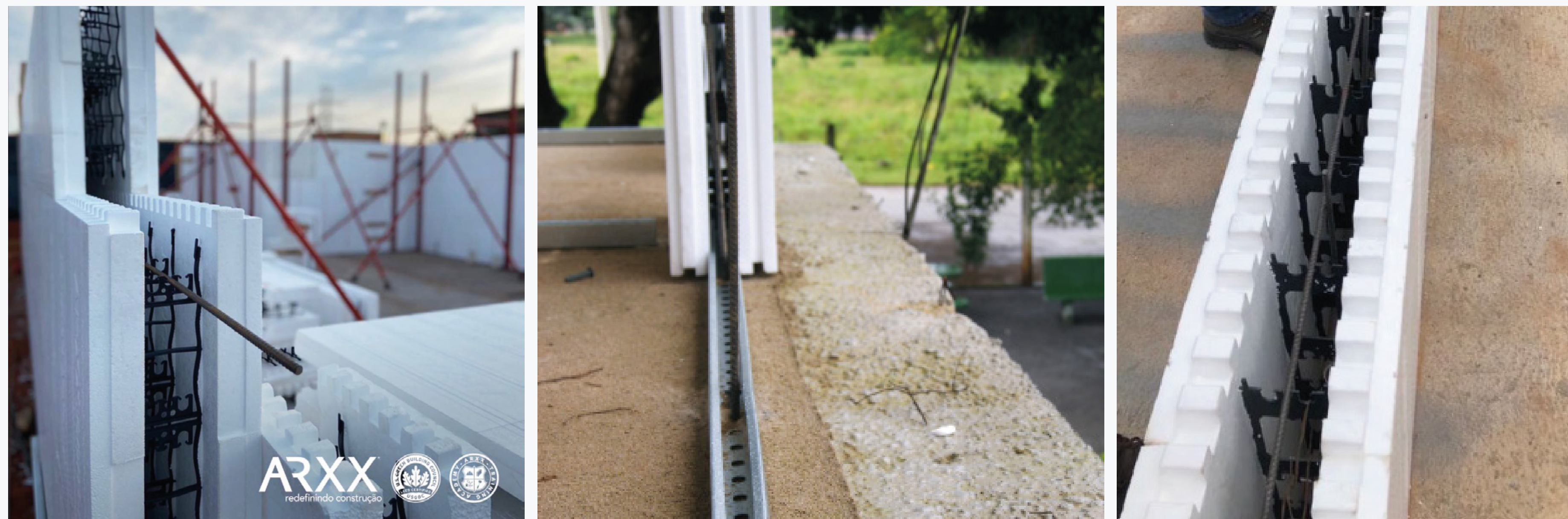
Imagem 18: Fixação dos blocos
