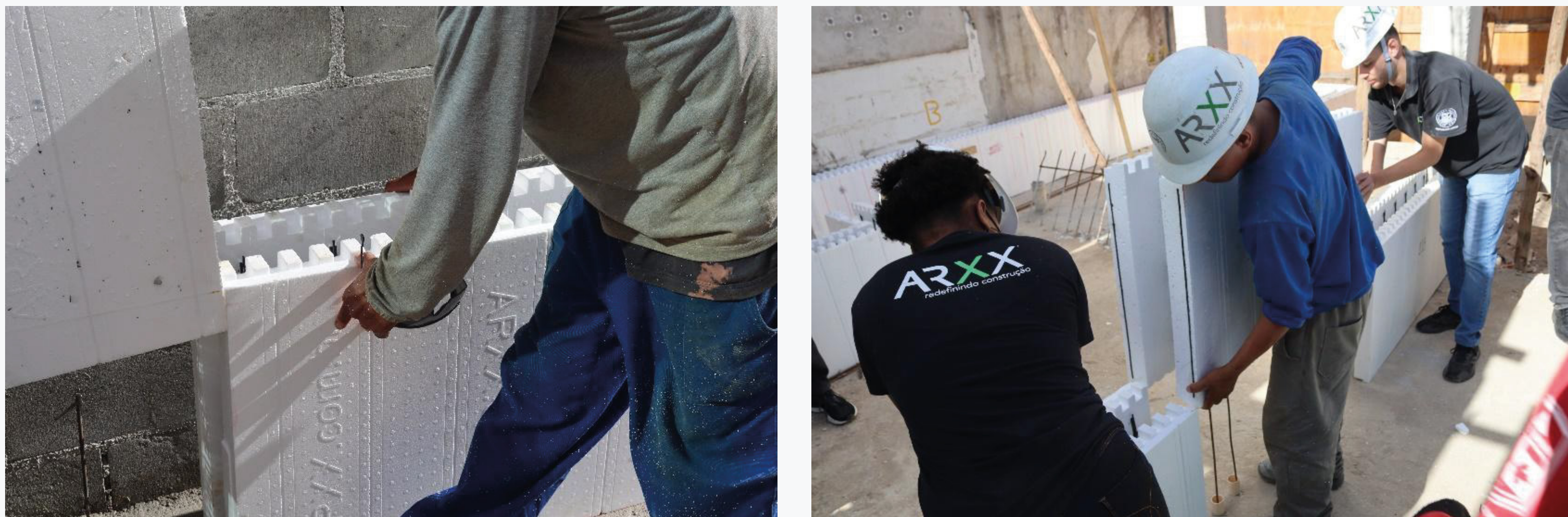
Figura 19: Assentamento dos blocos
