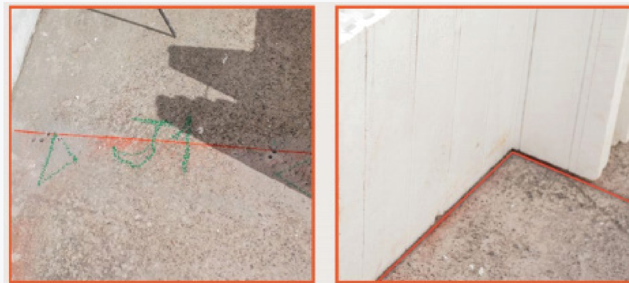
Figura 17: Marcação do alinhamento
