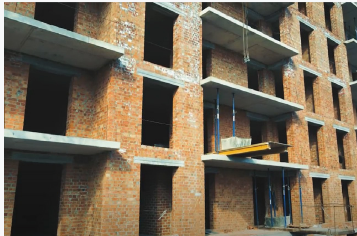
Figura 02: Parede de alvenaria
