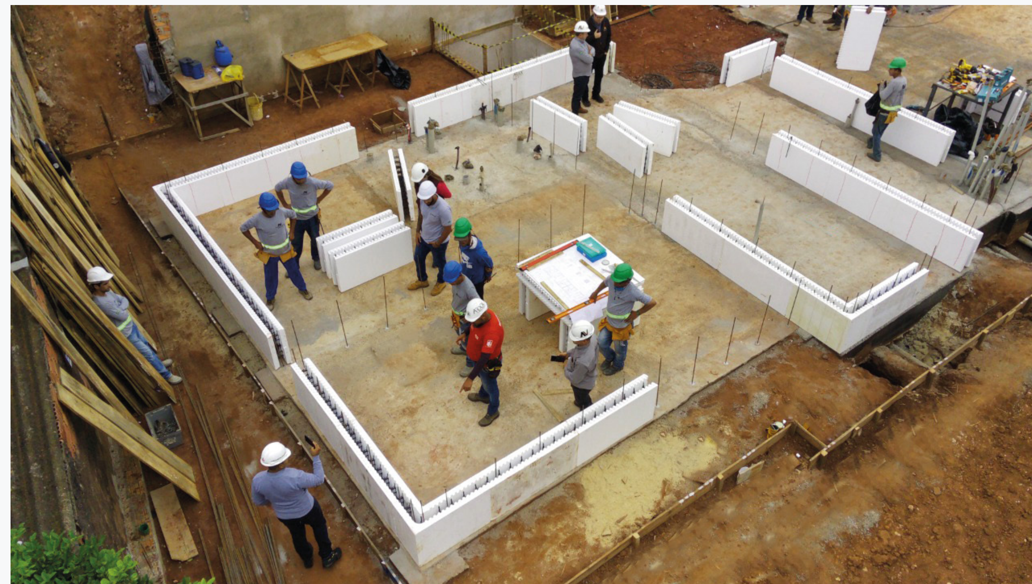
Figura 14: Obra de montagem de paredes de concreto ARXX
