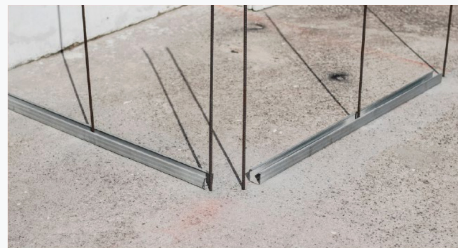
Figura 16: Posicionamento das barras de arranque
